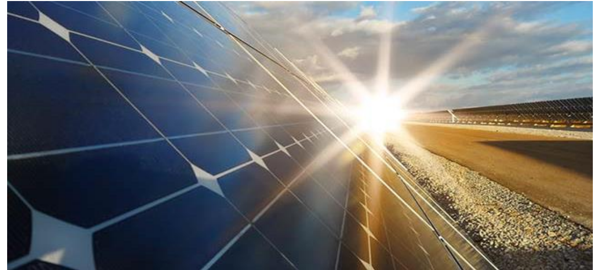
Tunisia – ADAM (5.5 MWp + 3MW/1,5MWh LiIon NMC)
